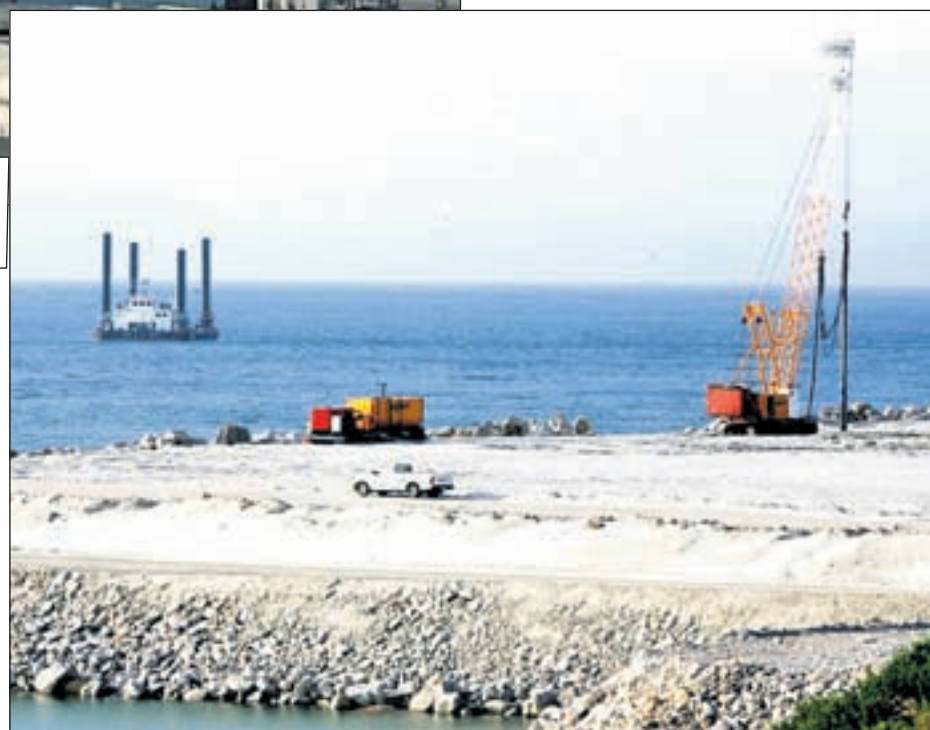
TangerMed II dont les travaux ont démarré en mai dernier prévoit une drastique augmentation de la capacité de transbordement à l'horizon 2014 avec plus de 8 millions de conteneurs par an (Ph. Bziouat)
