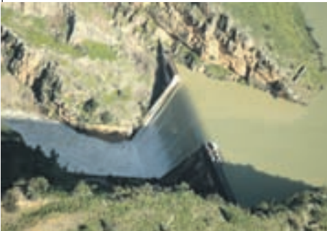
Barrage El Kansra
