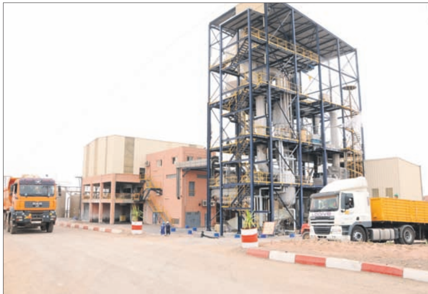
La septième usine de Guemassa. C'est à partir d'un process développé au sein du centre de recherche Reminex que le site minier de Guemassa peut récupérer les eaux utilisées sur le site et produire du sulfate de sodium. Un process qui a obtenu le prix de l'innovation développement durable de l'université de ONA en 2009 (Ph. Mokhtari)
