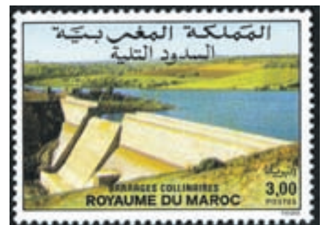
L'option pour la construction des barrages collinaires par Feu Hassan II a deux buts essentiels : le premier classique, le développement agricole, le second c'est faire face aux conséquences des inondations inattendues
