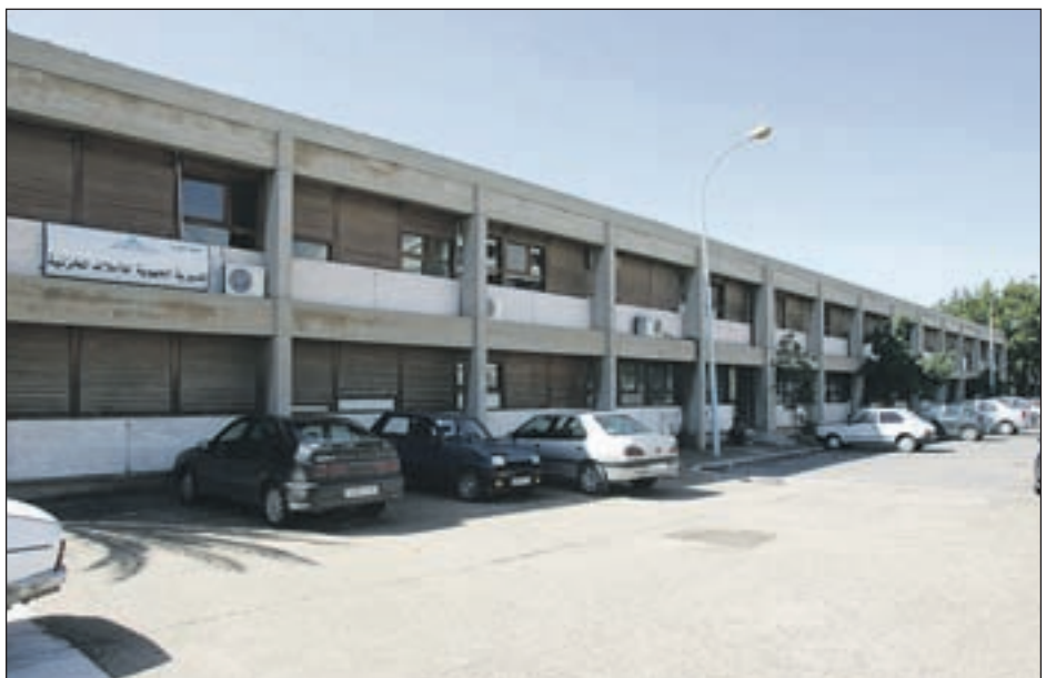
Les concepteurs de la cité administrative réalisée par Elie Azagury ont fait la part belle, comme pour les autres bâtiments du centre ville, au béton brut de décoffrage. L'ensemble abrite plusieurs administrations tels que le Trésor et la Conservation foncière. Le complexe qui s'étend au cœur du quartier ville nouvelle est une curiosité architecturale. Dommage que les établissements qui s'y abritent n'investissent pas assez dans son entretien (Ph. Bziouat)
