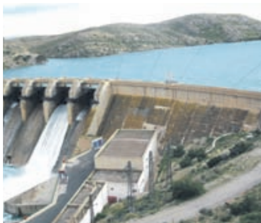
Barrage Mohammed V
