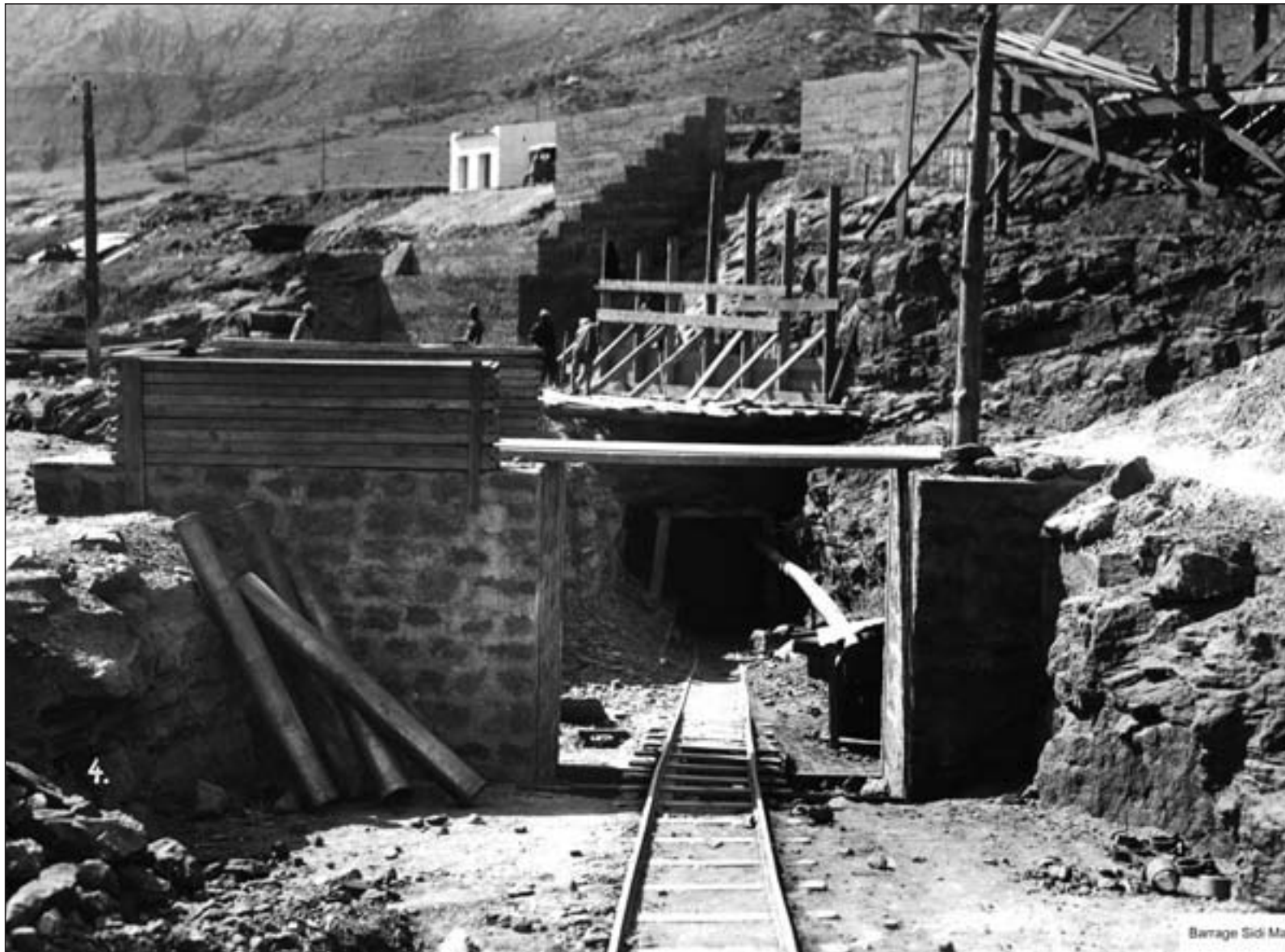
Construction du barrage de Sidi Maâchou. Les ouvrages hydrauliques modernes sont apparus sous la colonisation, alors que les moyens traditionnels avaient épuisé leur capacité à mobiliser l'eau. L'indépendance a vu l'explosion des capacités de mobilisation de l'eau. Aujourd'hui, si la construction des grands ouvrages n'est plus mise en avant que sous le règne de Feu Hassan II, l'effort d'équipement se poursuit, doublé d'un souci d'améliorer la gestion de l'eau (Ph. Marcel Flandrin ; collection privée, Fondation Banque Populaire pour l'Education et la Culture/ Groupe Banque populaire)
