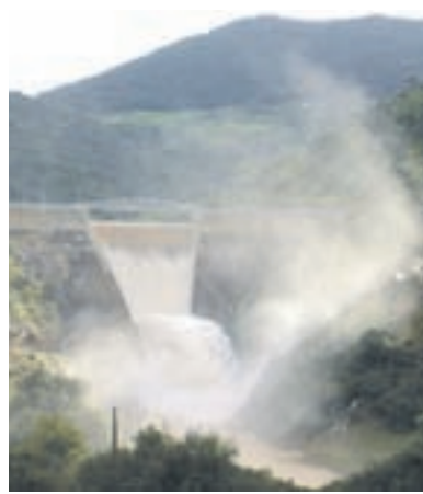
Barrage Bab Louta
