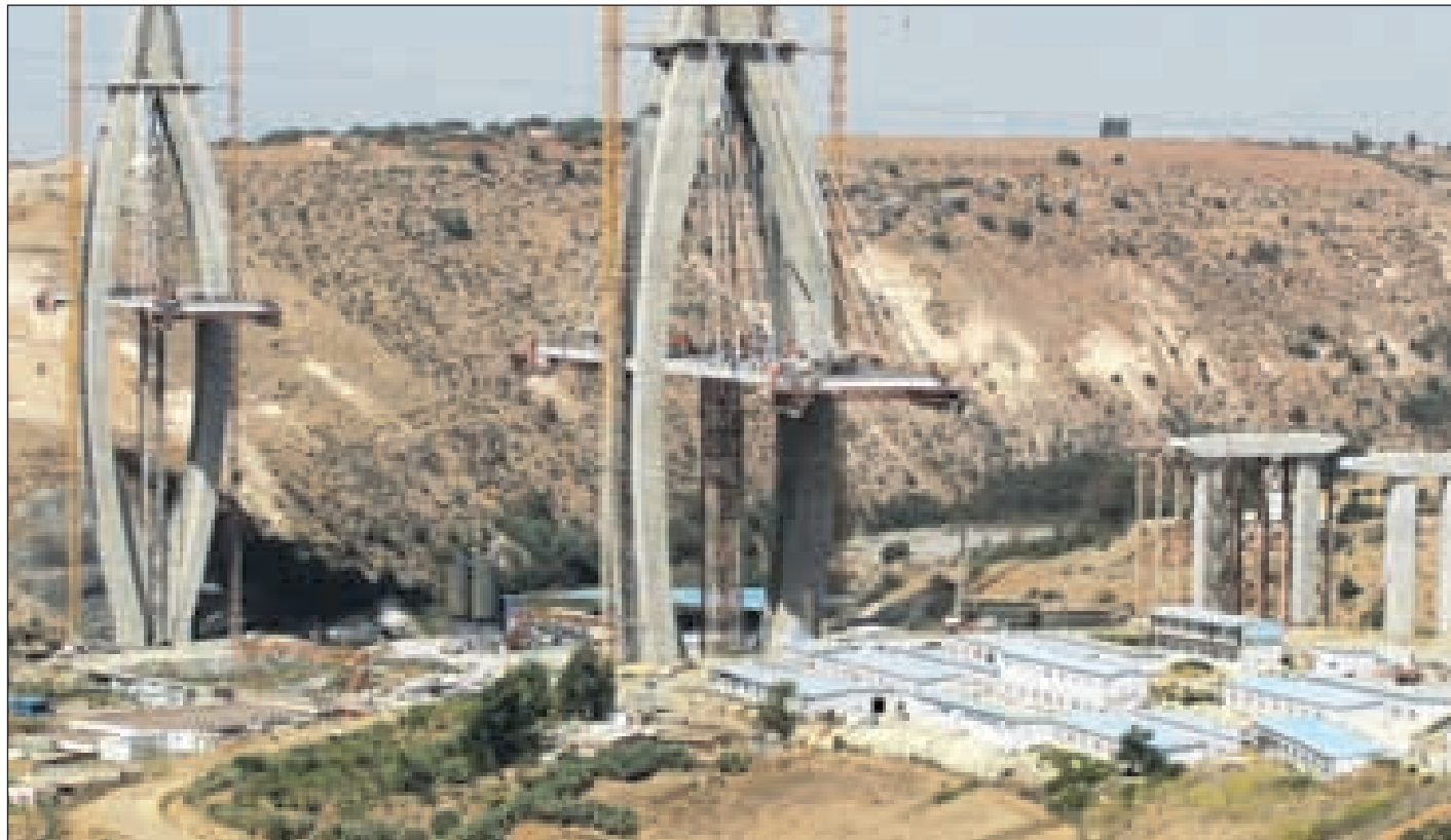
Le chantier de construction du pont suspendu d'Akreuch connu sous le nom de «la Route des Chinois». Un ouvrage qui fait partie du projet de contournement de l'autoroute, dont la particularité est d'abriter un petit Chinatown en pleine campagne (Ph. Bziouat)
