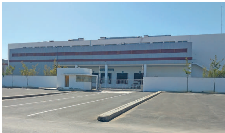
La réalisation de ce projet va permettre la modernisation de l'activité d'abattage des animaux au niveau de l'agglomération de Rabat (Ph. NEA)
