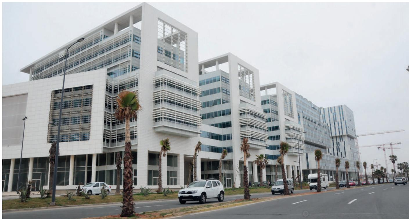
Le béton utilisé dans la construction de la marina de Casablanca obéit à la NM 10-1-008. L'usage de ce béton, dans ce milieu agressif (important taux d'humidité), permet de garantir une durée de vie moyenne de 120 ans à ces bâtiments (Ph. L'Economiste)
