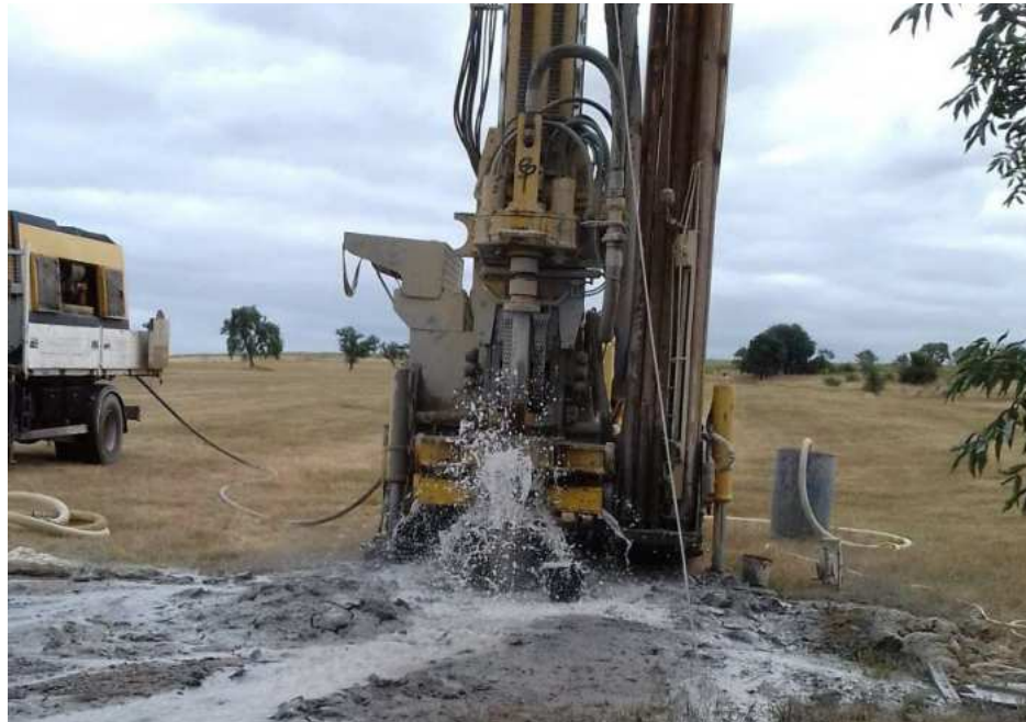
Outre la déclaration relative au début et à la fin des travaux de creusement, le puisatier devra élaborer un rapport notamment sur les résultats du forage, le débit de l'eau, etc. (Ph. Privée)
