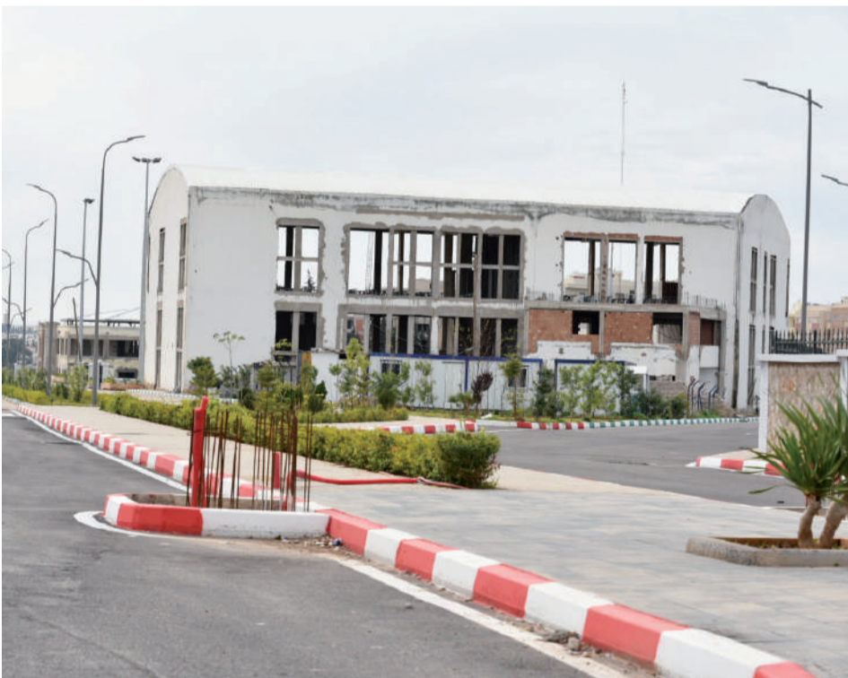
Le parc international d'exposition de Fès devrait coûter 64 millions de DH. Un montant pris en charge par la CCIS, le ministère de l'Industrie et plusieurs partenaires. Ce parc vise à satisfaire les besoins pressants de divers secteurs d'activité et relancer des entreprises constituant l'ossature de base du potentiel économique de la région. Son but est de consolider la compétitivité de la région Fès-Meknès, en tant que destination attractive pour les investissements directs à l'étranger (IDE). L'objectif étant de drainer également bon nombre d'exposants, marocains et étrangers, et ainsi développer le tourisme d'affaires (Ph. YSA)
