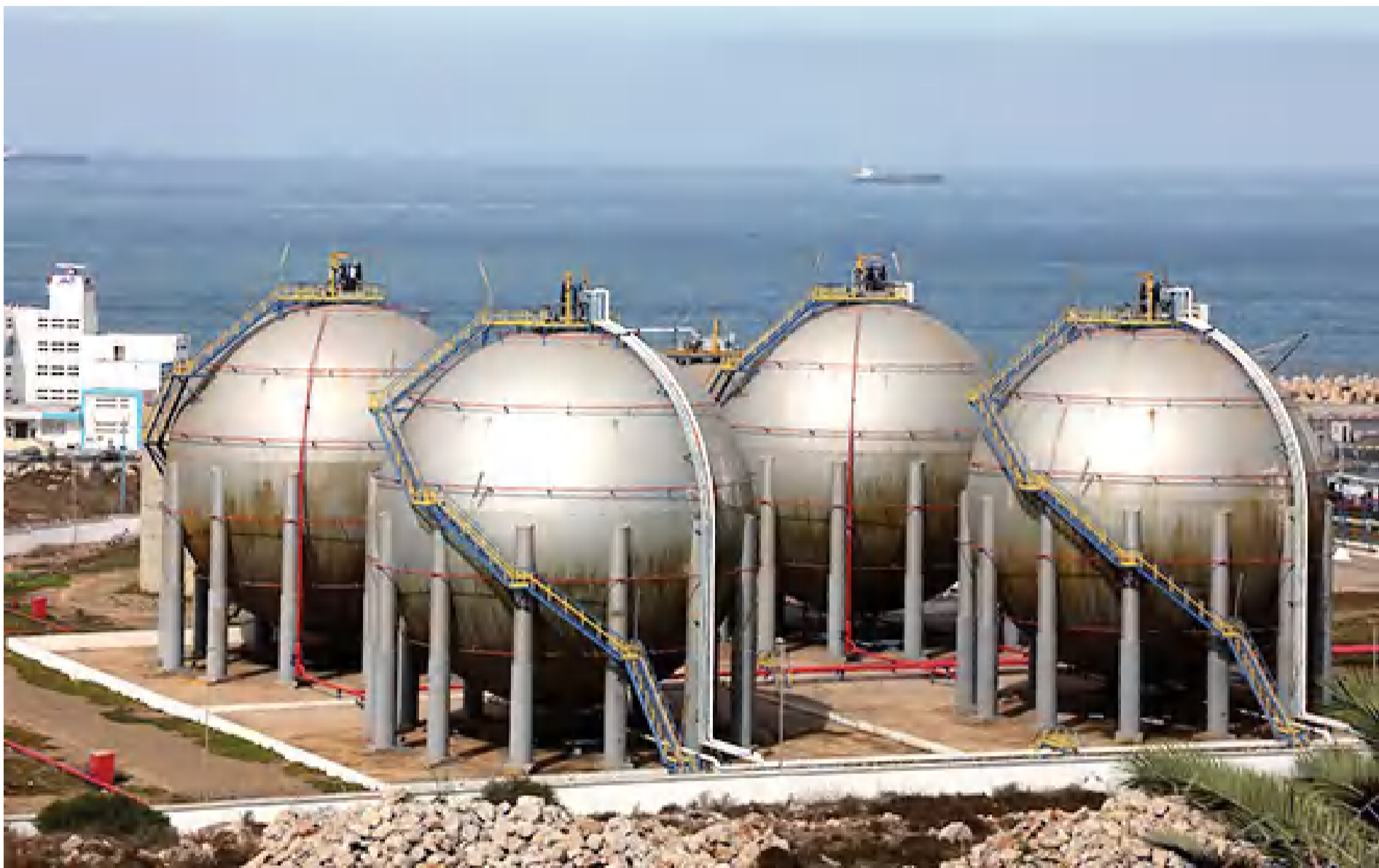
Le secteur énergétique est également une composante stratégique de ce territoire. En plus de la présence d'un opérateur de référence comme Taqa Morocco, le nouveau port énergétique projeté dans cette zone, considéré comme le plus grand terminal d'importation, de stockage et d'exportation de carburants au Maroc (Ph. Bziouat)
