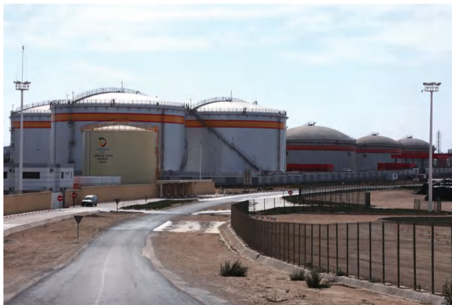
Une grande partie des industries lourdes, notamment les filières de chimie et parachimie, la métallurgie, l'énergie, est implantée dans le parc industriel de Jorf Lasfar (Ph. Bziouat)
