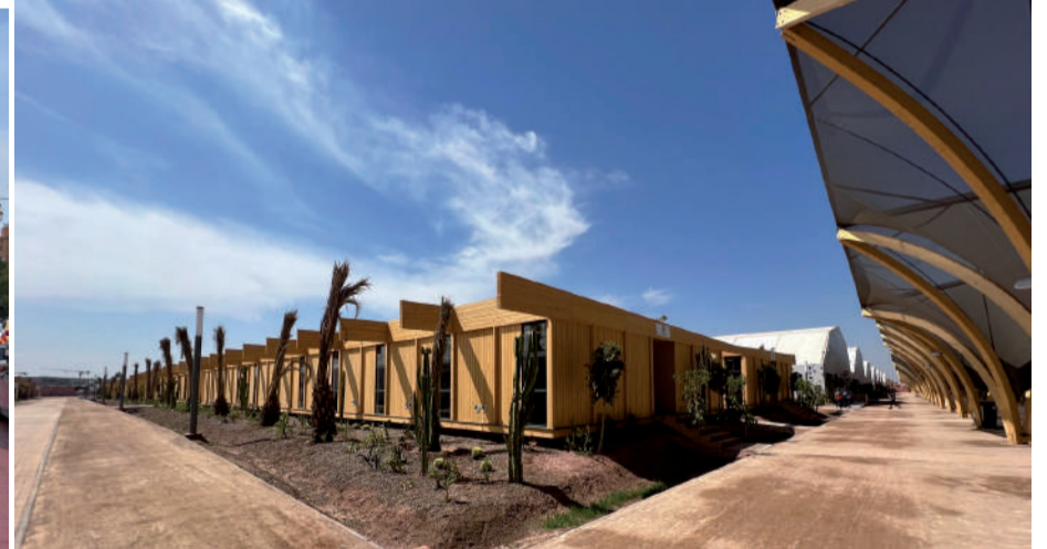
Les structures en bois installées à Bab Ighli seront mises à la disposition de l'Éducation à la fin de l'événement
